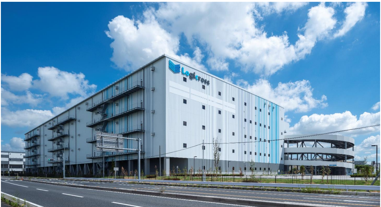
▲「ロジクロス三郷」外観
