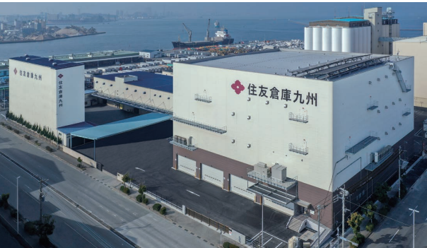
住友倉庫九州 箱崎埠頭営業所新倉庫
