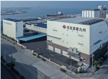
九州一円の物流需要をカバーする 住友倉庫九州箱崎埠頭営業所新倉庫
