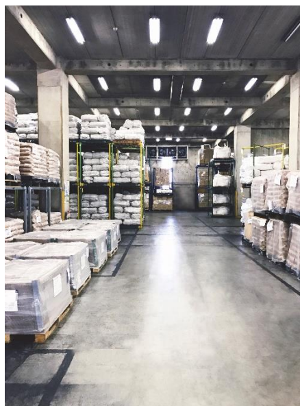
更新前（蛍光灯）
