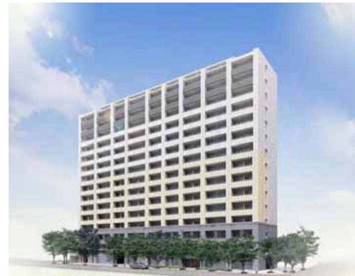
南堀江マンション
