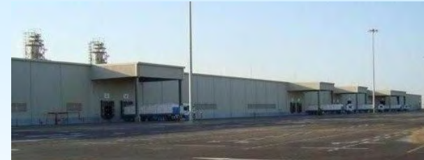
ペトロ・ラービグ社工場構内倉庫
