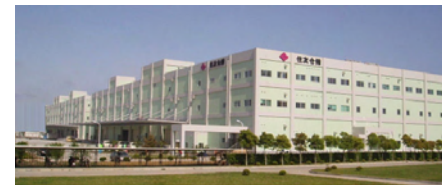
住友倉儲(中国)上海倉庫
