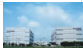
羽生トランクルーム営業所
