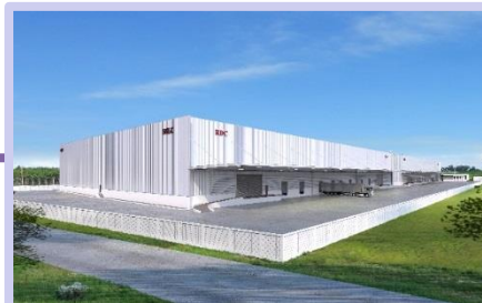
タイ・レムチャバン2期倉庫
